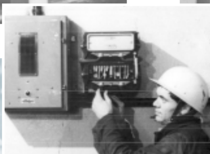
Монтаж линий связи
